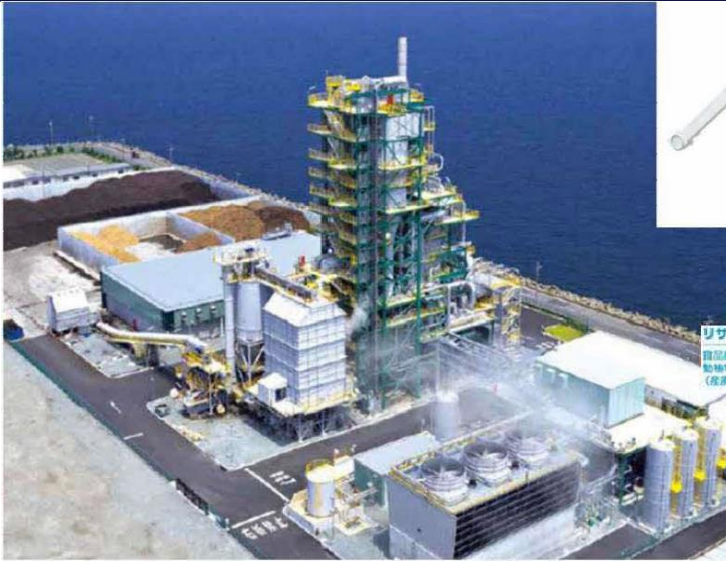
CFBタービンボイラー型:燃料(PKS,木材チップ,ペレット)
